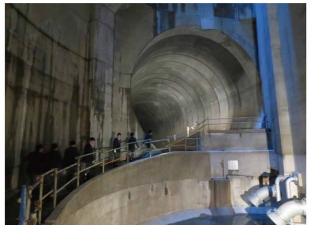
現場見学会(白子川調整池)
